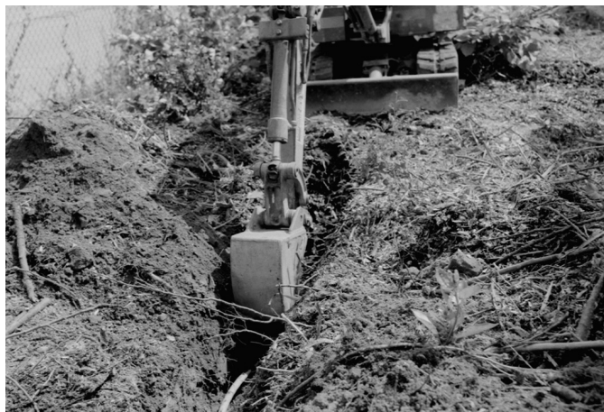
Оболочка кабеля, поврежденная экскаватором, просто и быстро ремонтируется
