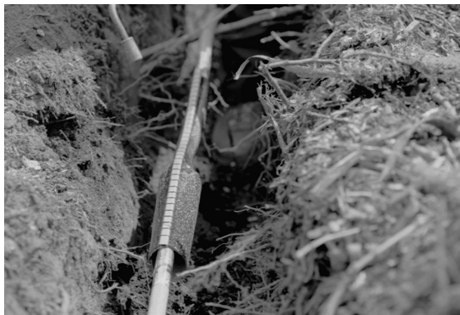
Поврежденный участок кабеля оборачивают манжетой CWST и производят термоусадку при помощи стандартной горелки, применяемой спайщиками
