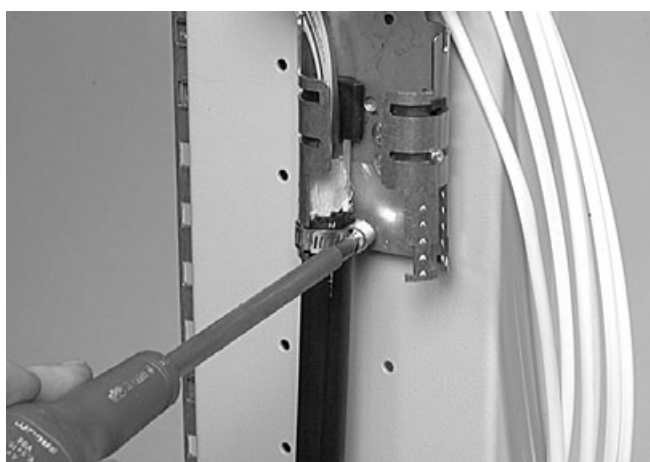
4.1.14 Зафиксируйте кабельным хомутом. Не сжимайте кабель.
