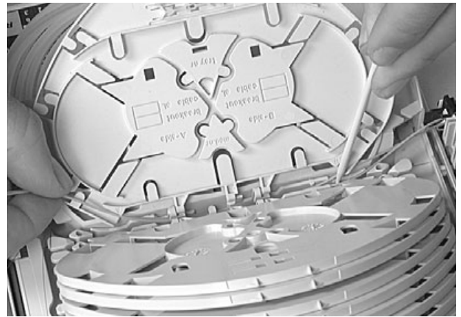
6.13 Заведите волокна в соответствующие канавки. Убедитесь, что все волокна находятся под выступами канавок.
