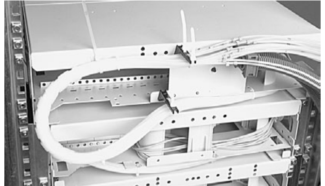
4.1.16 При вводе второго кабеля замените разъемный поясик вторым пластиковым держателем.
