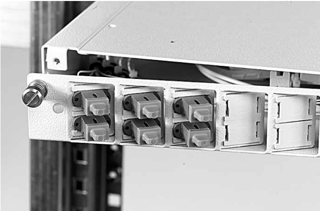
3.2.1 Установить коннекторы (розетки) на панели для коммутации. На неиспользуемые порты должны быть установлены пластиковые заглушки.
