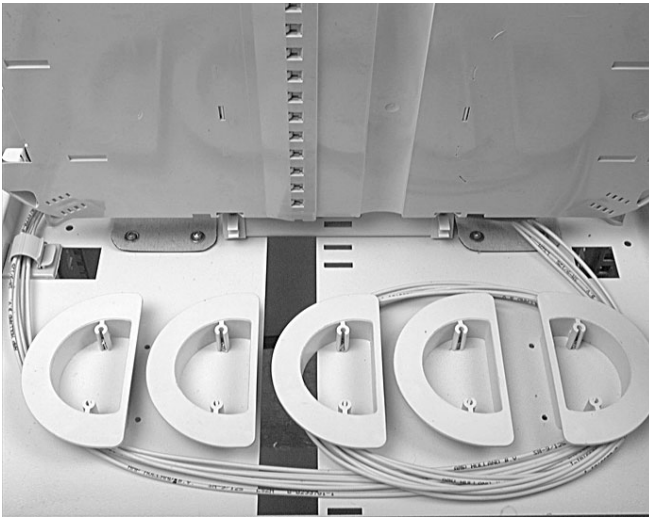
3.8.2 Уложите шнуры вокруг элементов контроля изгиба, чтобы сохранить запас длины.
