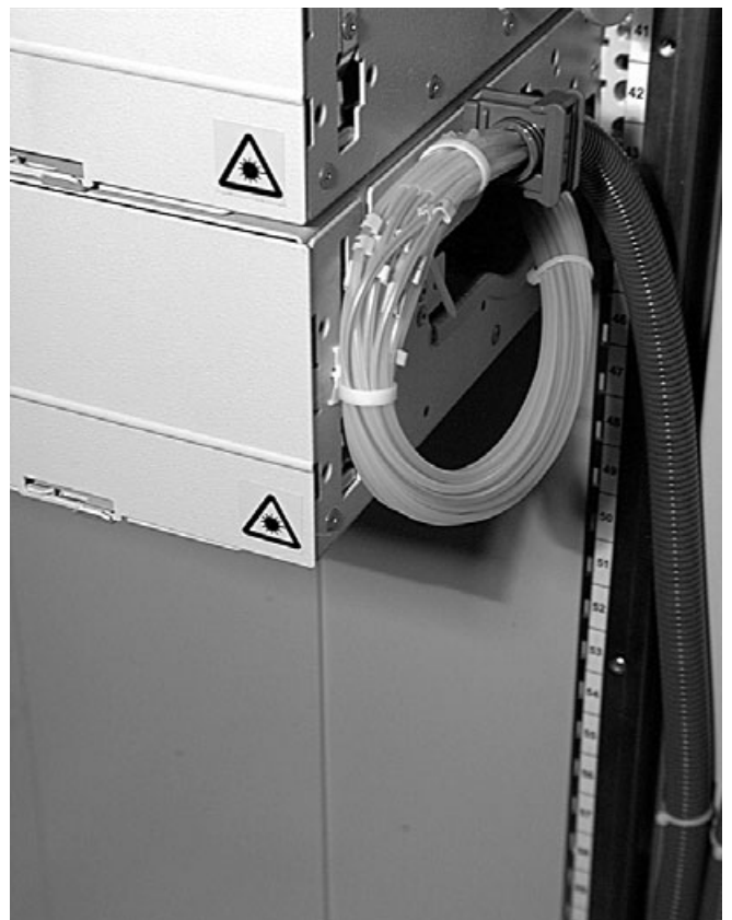
8.1.10 Прикрепите гибкую трубку к панели (смотри инструкцию к панелям GSS2, GPS2, GMS2).
