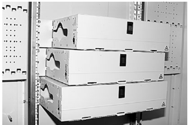
7.7.1 При установке 19" панелей необходимы адаптеры-переходники.
