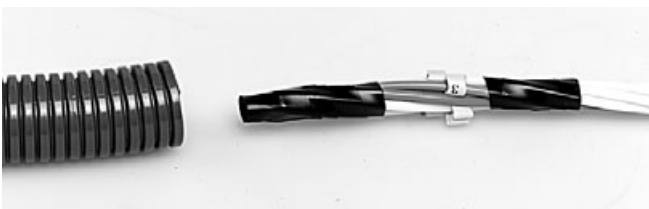
8.1.8 Отметьте модули и заведите их через гибкие трубки к панелям.
