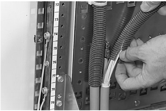
8.1.6 Сделайте продольный разрез на гибкой трубке и наденьте трубку поверх оптических модулей до оболочки кабеля.
