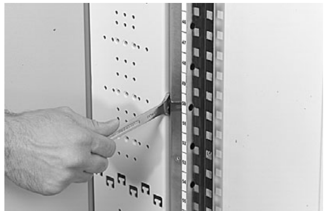
3.3.5 Затяните винты ключом № 13.
