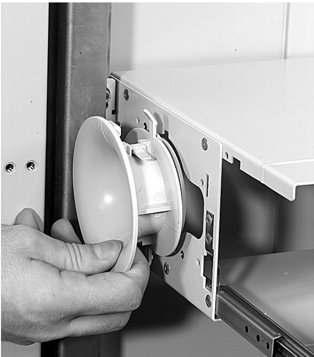
3.3.4 В случае применения одиночных пигтейлов и станционных кабелей не собранных в жгут, со стороны ввода пигтейлов необходимо использовать раструб.
