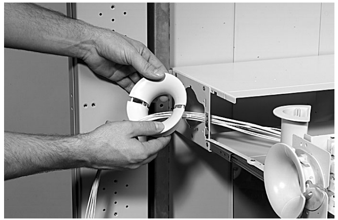
3.3.5 При необходимости раструб может быть легко снят и разъединен.
